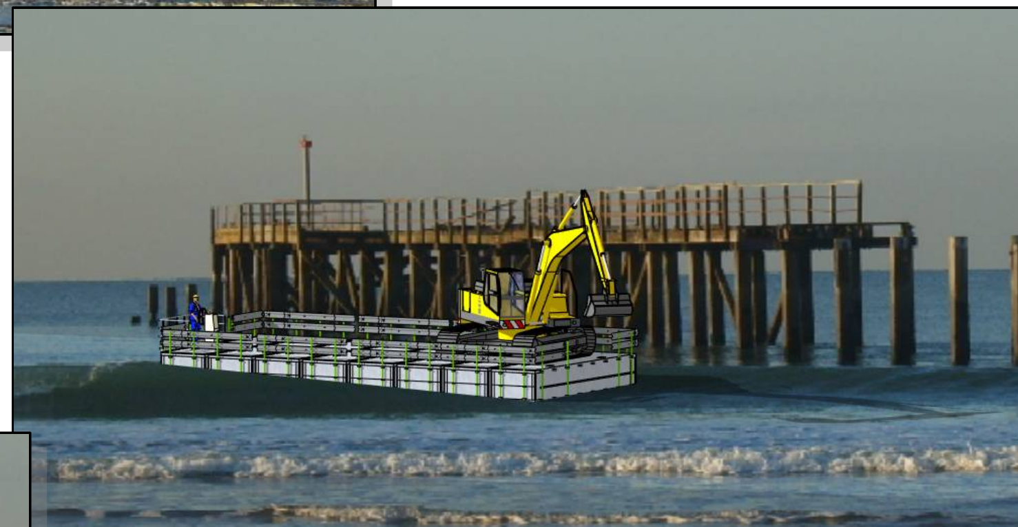
2 - EVACUATION DES GRAVOIS - Module 1 Marée haute - barge en flottaison
