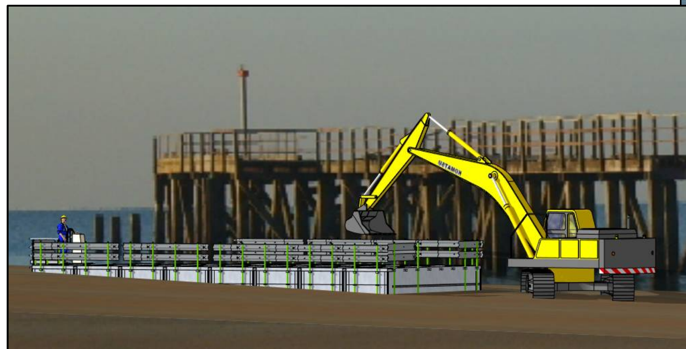
1 - DEPOSE DE L'EXISTANT - Module 1 Marée basse barge échouée
