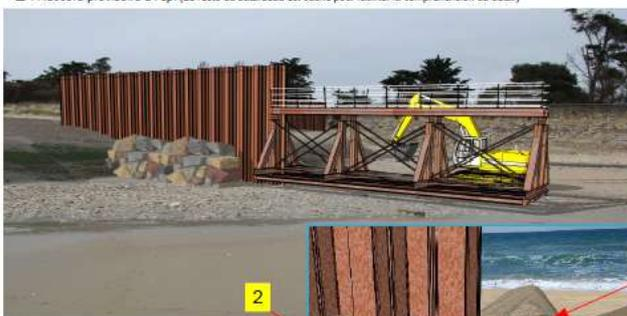
Une poutre en béton armé au pied des palplanches au passage sur l'épi assure aussi l'étanchéité et la cohésion avec l'existant. L'épi est ainsi préservé dans sa fonction et le batardeau y trouve un support apte à résister aux tempêtes. Des enrochements viennent compléter la protection et assurent une fonction de brise lame.
