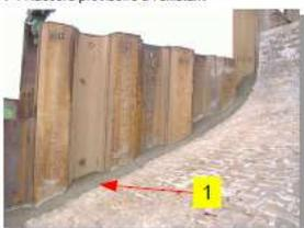
Le clavetage entre les palplanches et la digue assure l'étanchéité et la cohésion de l'ensemble de l'ouvrage en cas de tempête pendant la phase de création du batardeau.
