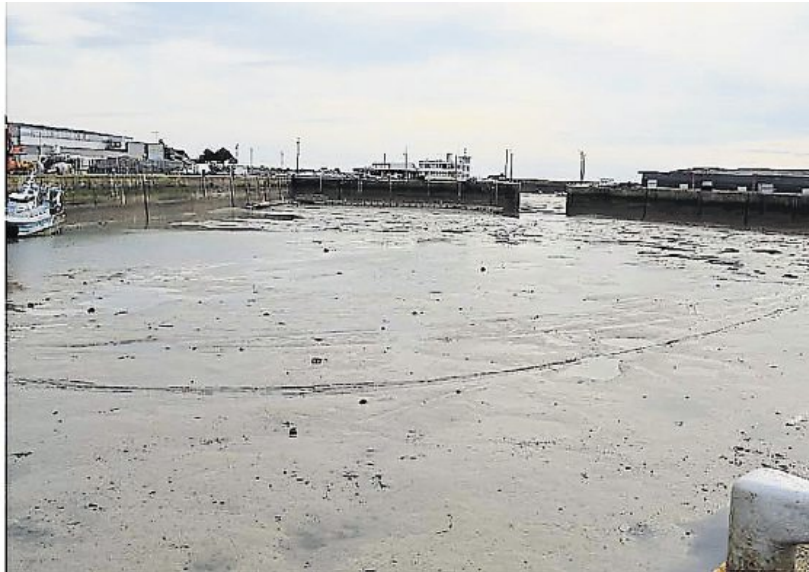
Pour la seconde fois cette année, le bassin a été mis à sec pour permettre la prise de cotes sur les écluses
