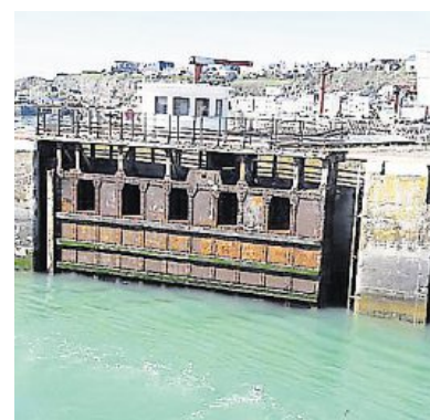
La porte d'écluse sera remplacée au début 2018.
